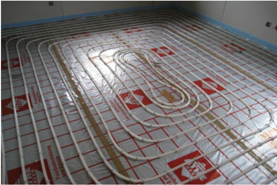
Die hier verlegte Fußbodenheizung ist optimal verlegt. Eine gleichmässige Trocknung und Beheizung der Estrichfläche ist garantiert. Das Rissrisiko gering. Das ist eine tolle Arbeit des Heizungsbauers.
