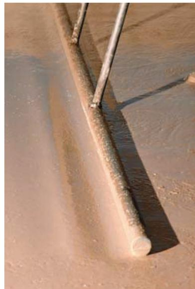
Durch leichtes vibrieren wird der Mörtel einnivelliert
