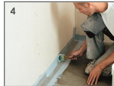
4 Schönox ST Fugendichtband in die frisch aufgebrachte Schönox HA einlegen und fest andrücken.
