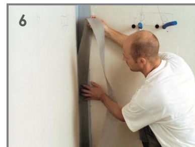
6 Schönox ST Fugendichtband in die aufberachte Schönox HA einlegen und fest andrücken
