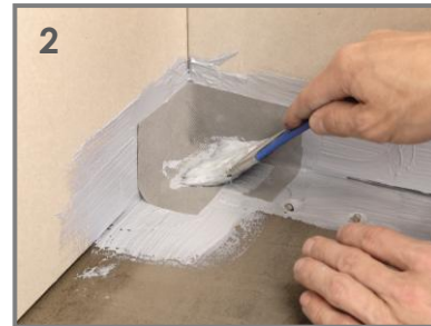
2 Schönox ST IC Innenecken in die frisch aufgebrachte Schönox HA einlegen und fest andrücken.
