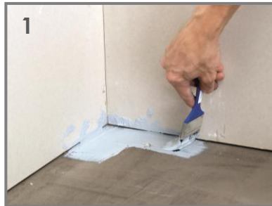
1 Im Eckbereich Wand zu Boden: Schönox HA in gleichmässiger Schicht auftragen.
