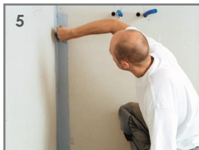
5 Im Bereich Wand zu Wand: Schönox HA auf Schönox ST IC Innenecke sowie den abzudichtenden Wandbereich auftragen.
