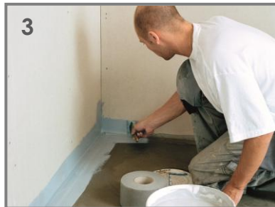
3 Im Bereich Wand zu Boden: Schönox HA auf Schönox ST IC Innenecke sowie den abzudichtenden Bodenbereich auftragen.
